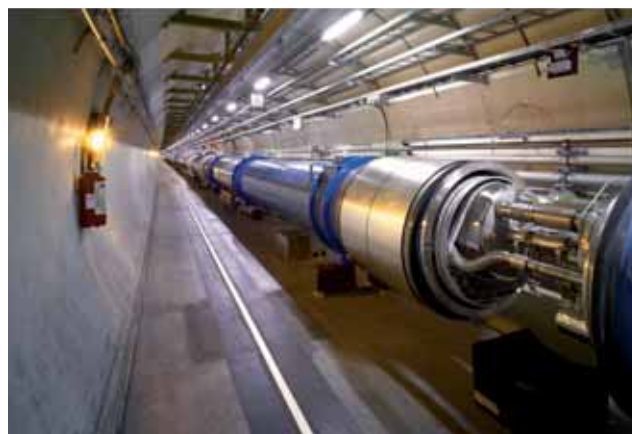
fig.2 : vue du tunnel du LHC
