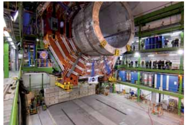
fig.5 : descente d'une des 9 tranches de CMS dans la caverne de l'expérience, située 100 mètres sous terre
